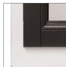
Scharnieren weggewerkt, het zgn. verdekte beslag
